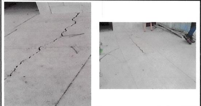
Foto1: Sustitución de piso cemento por piso de granito. ✓
