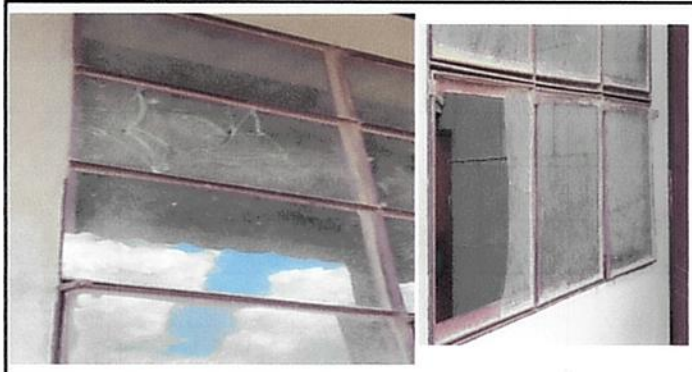
Foto 2: Sustitución de ventanas por ventanas de PVC ✓
